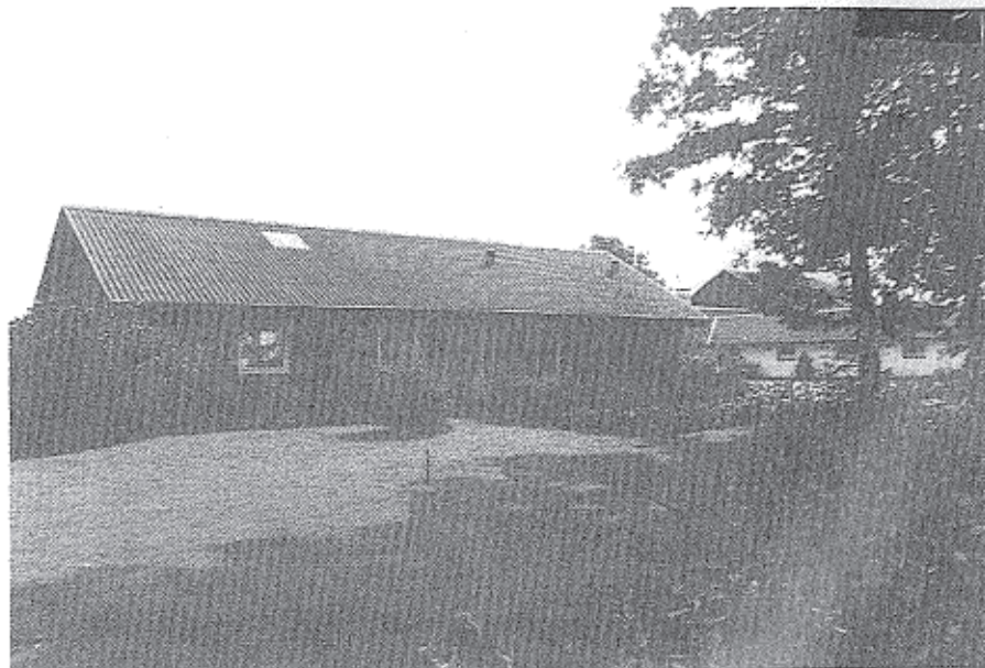
Bredevadvej 41. Udflyttergården fra lensfogedgården i Bredevad. Nyopført stuehus og etapevis nyopførte og reetablerede driftsbygninger efter brand i 1982.
