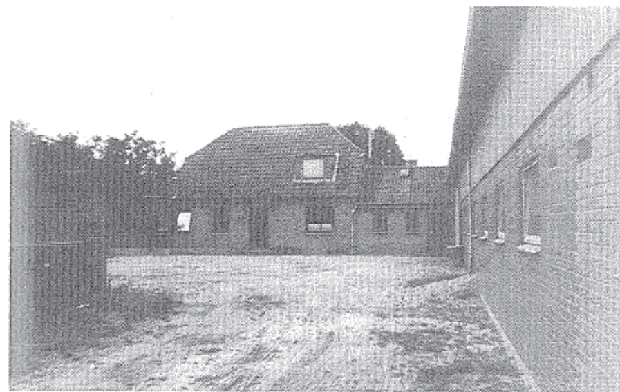
Sottrupholmvej 7. Opført efter brand i 1950. Det er en udstykningsejendom fra 1880'erne og oprettet på sammenkøbt jord.
