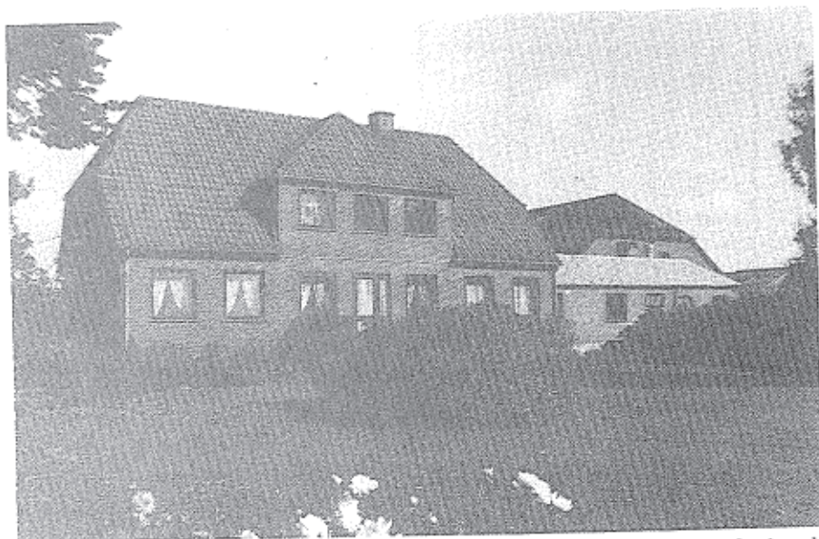
Østergårdsvej 8. Tidligere Løgumkloster-fæstegård. Bygningerne er opført i 1950'erne efter brand. Fra denne gård er Galgebrostene 5 udstykket.
