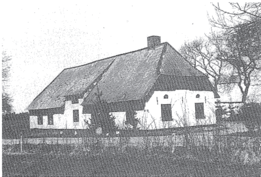
Søllingvråvej 8. Kådnersted under Mårkær, der var ved at blive til en lille gård omkring 1900. Nu beboelseshus.
