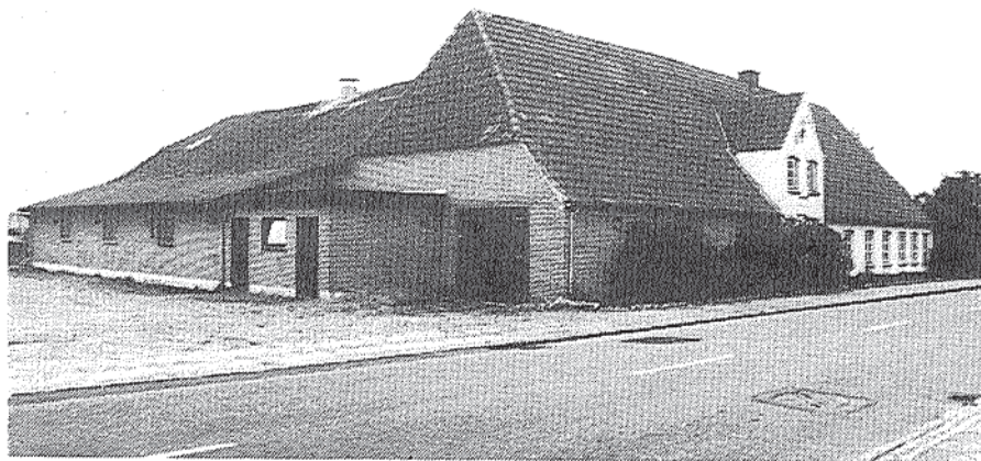
Lendemark 49. Den tønderske gård, opført efter en brand i 1877 og samtidig flyttet over vejen. Fra 1753 til 1910 boede slægten Eschelsen på denne gård.
