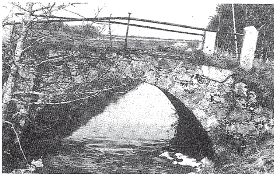
Kobro over Søderup å mellem Heds og Bredevad. Den må være bygget omkring år 1800, måske lidt før, da der var en bro i 1793.
